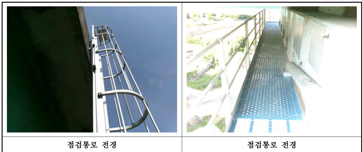
【사진 1.3.25】 교량 점검시설 전경
