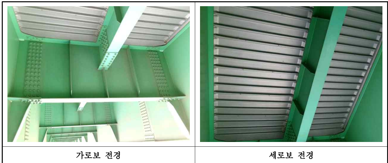
【사진 1.3.6】 가로보 및 세로보 전경
