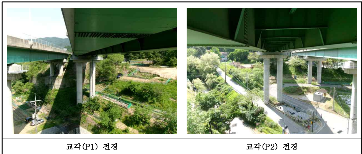
【사진 1.3.10】 교각 전경
