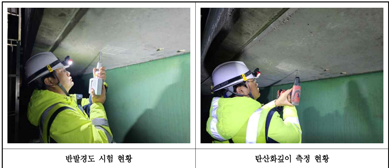
【사진 1.4.1】 콘크리트 내구성조사 현황
