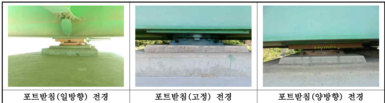
【사진 1.3.12】 교량받침 전경
