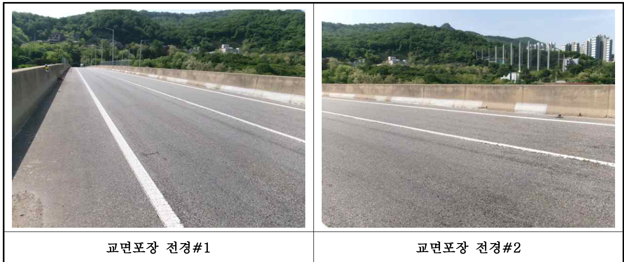
【사진 1.3.19】 교면포장 전경
