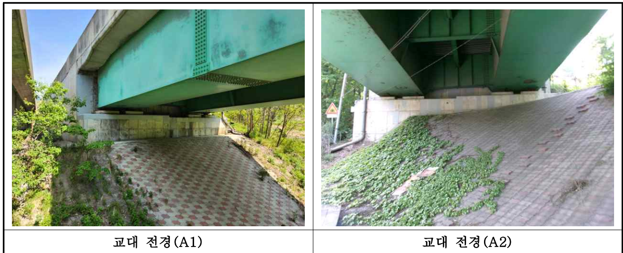
【사진 1.3.8】 교대 전경
