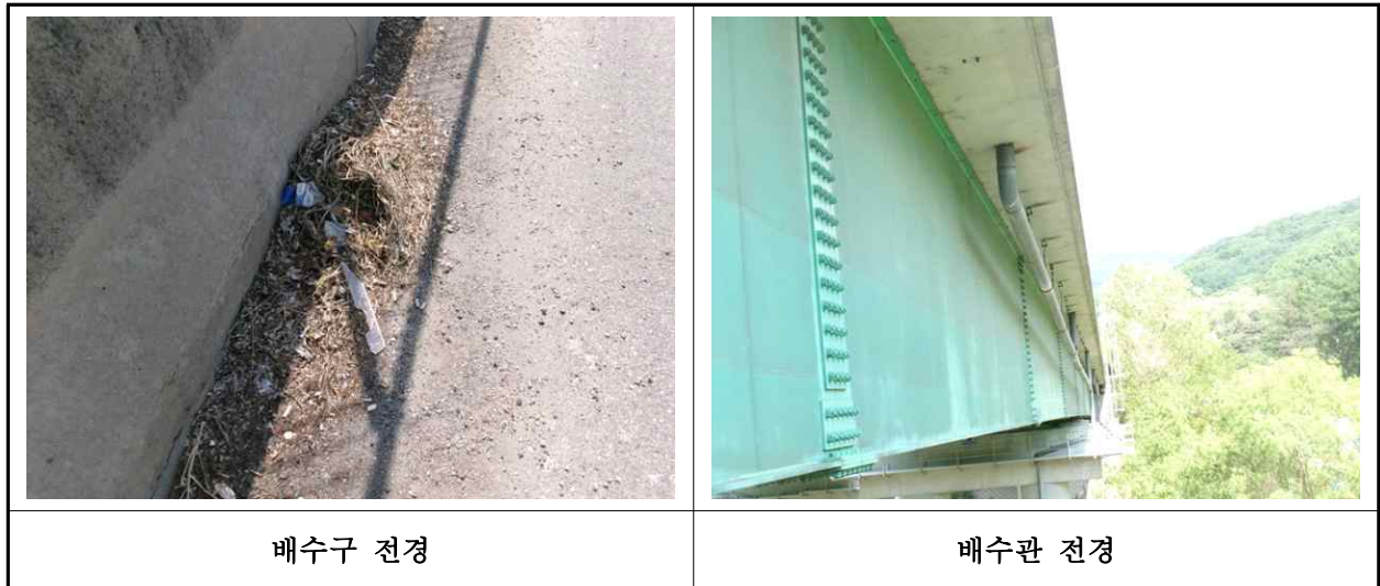
【사진 1.3.21】 배수시설 전경
