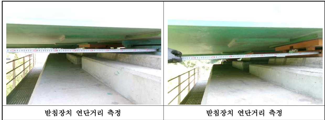
【사진 1.3.14】 교량받침장치 연단거리측정
