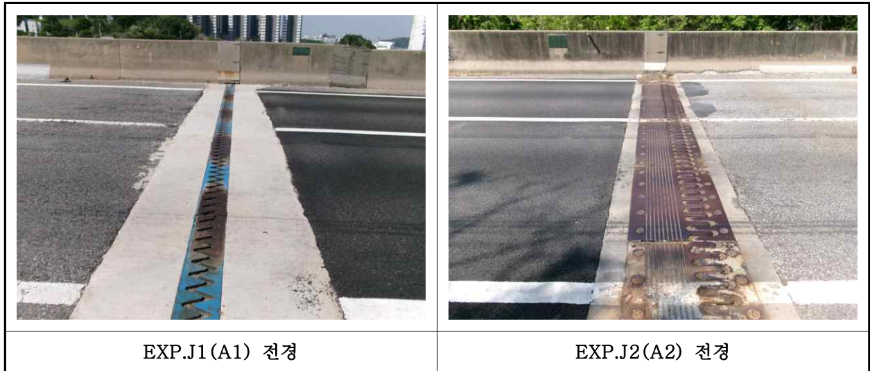
【사진 1.3.16】 신축이음장치 전경
