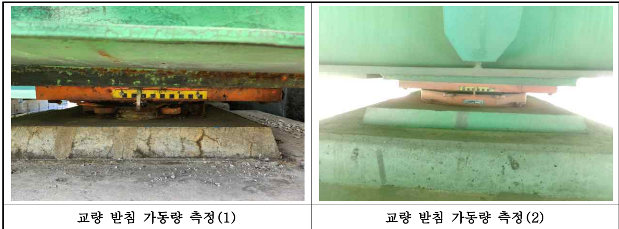
【사진 1.3.15】 교량받침 이동량 측정
