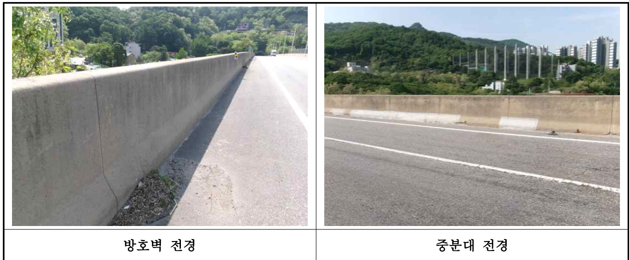
【사진 1.3.23】 방호벽 및 중앙분리대 전경
